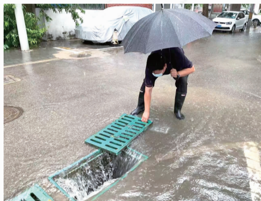
工作人员疏通下水口
